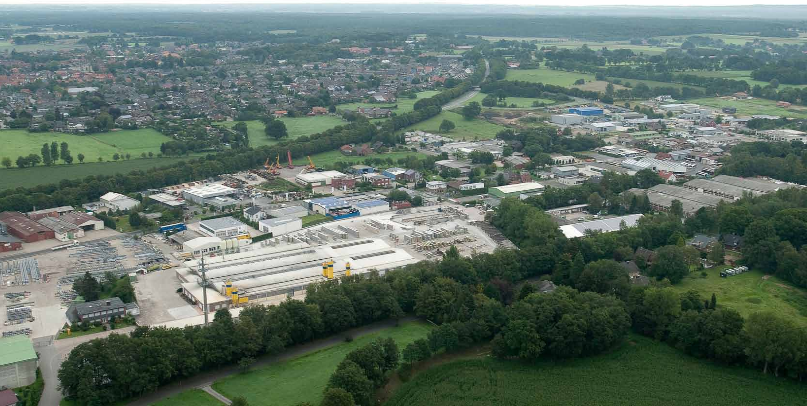
Überfahrt bei Schermbeck im Industriegebiet
